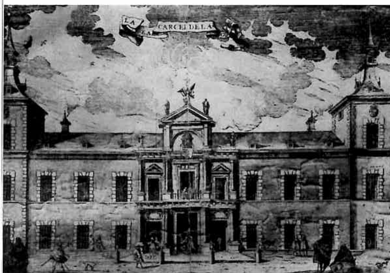
MADRID. - LA REAL CÁRCEL DE LA CORTE.
